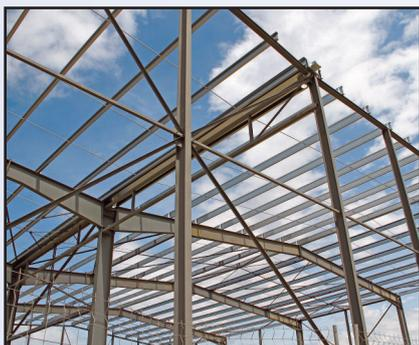
**Panne métallique** : Pièce horizontale d'une charpente de comble autrefois nommée filière. La panne repose sur les arbalétriers des fermes et sert de support aux techniques de couverture.
