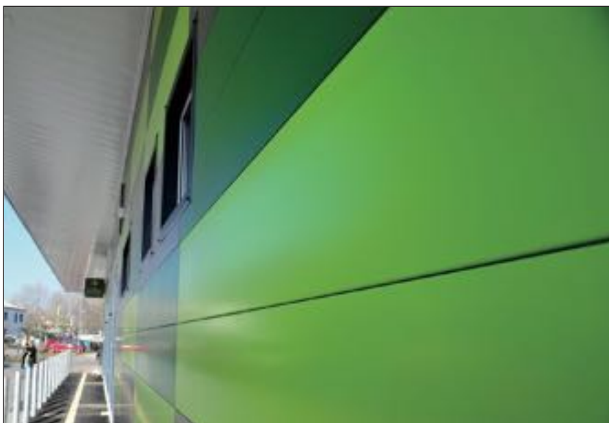
Réalisation en lame Iroise 300 post laquée pose horizontale.
